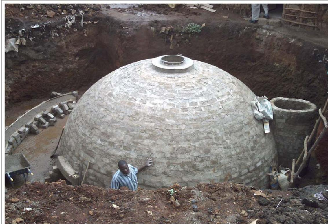
*Digestor de biogás sendo construído pela Umunde Trust, em Nairóbi. Um centro biológico é construído sobre um digestor, com banheiros públicos no andar térreo e cozinha, escritório e sala de reunião no primeiro andar. Combustível para geração de energia e uso na cozinha é diretamente derivado dos gases gerados das urinas e fezes coletados nos banheiros públicos e armazenados na câmara de expansão.*
