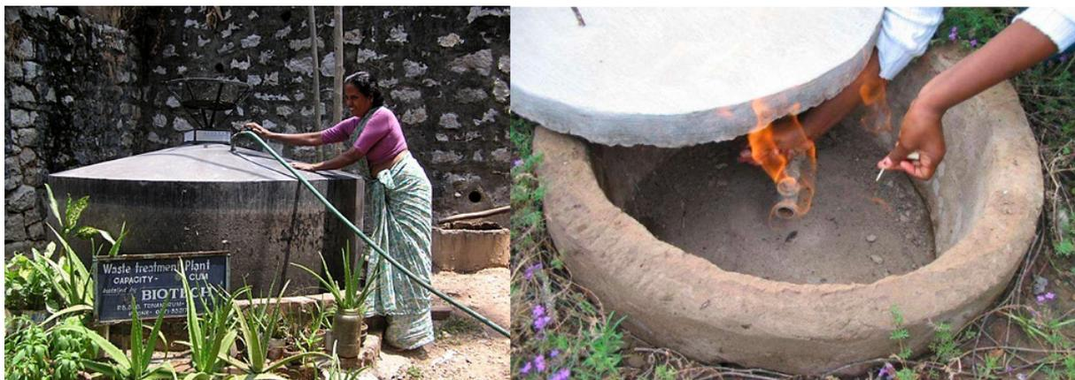
Checagem da válvula de gás de uma cobertura flutuante em um [biodigestor de gás](#) na Índia (esquerda) e ignição da chama de [biogás](#) (direita, Lesoto, 2006). Fonte: BIOTECH India (2007) e Muench (2008).
